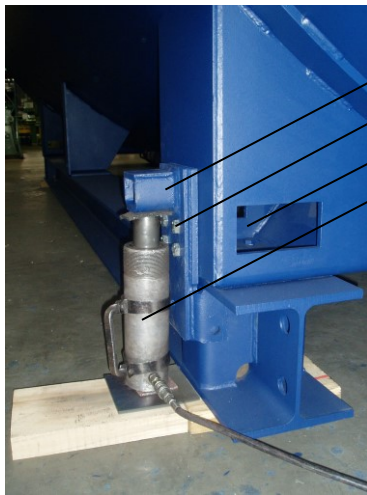
Рисунок 3: Подъем котла с помощью подъемного приспособления (изображение для одной опоры котла)
